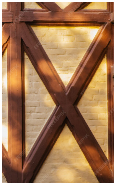
Figure 3: Mur diagonalisé par une structure bois
