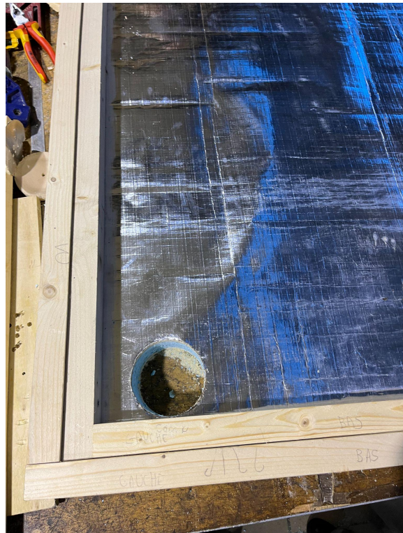
Figure 7B: Perçage des conduits, vue de face
