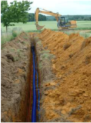
Enterrement du tuyau
